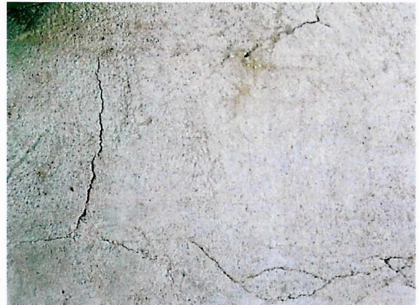
Fotografía N° 7: Detalle de fisuras en bowl.
