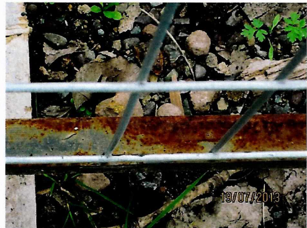
Fotografía N° 5: Detalle del óxido en la reja.
