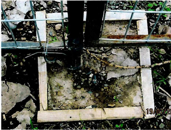
Fotografía N° 4: Detalle de los restos de moldaje.
