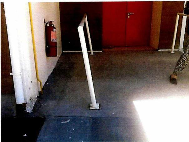
Fotografía N° 4: Baranda de rampa de minusválidos desanclada con riesgo de colapso.
