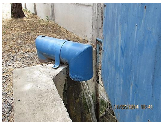
Figura 13. Descarga de Agua Servida Tratada en Planta de Lodos Activados.
