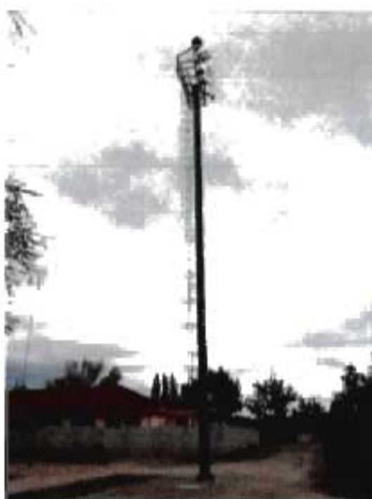
Construcción Torres de iluminación campo deportivo Estadio Municipal - Diseño de torres acorde a proyecto
