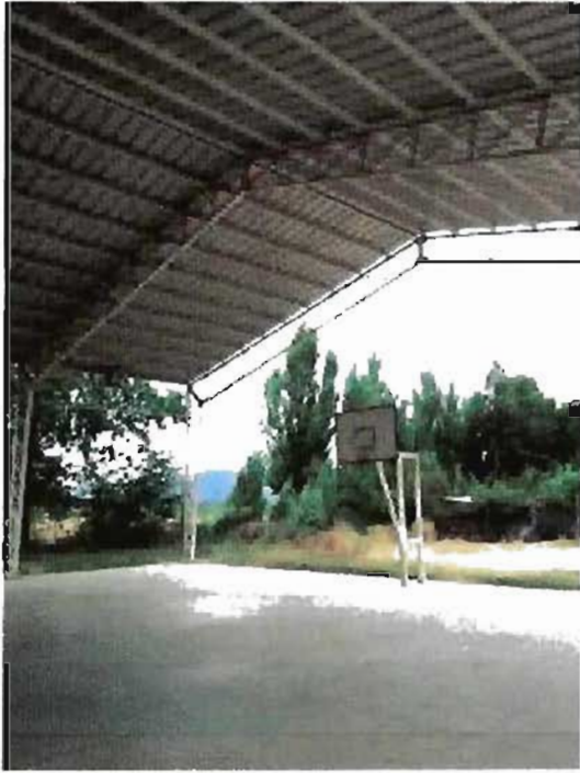
Multicancha Santa Victoria – 6 pórticos metálicos
