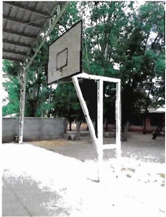
Multicancha Santa Victoria – tablero de basquetbol en línea de fondo de cancha, sin implementación deportiva, protección contra golpes y no cumple con diseño de proyecto.
