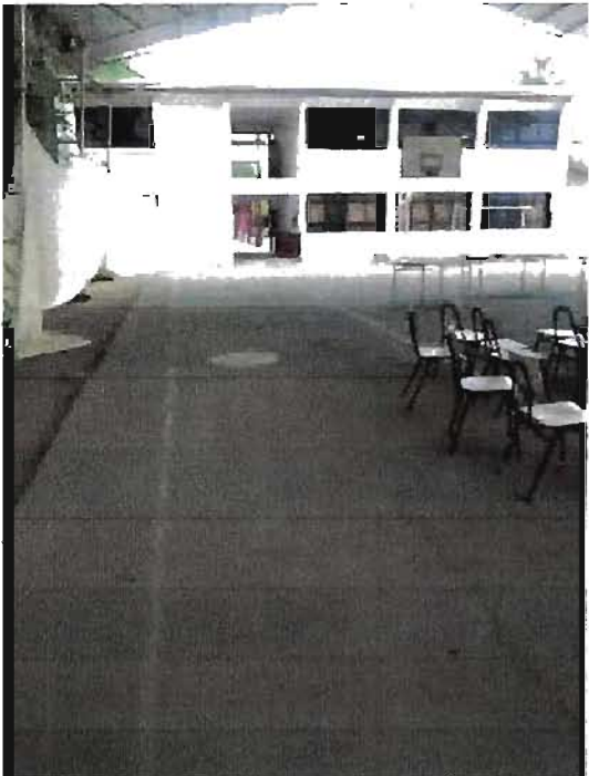
Multicancha Liceo Víctor Jara – situación paños reparados (hasta media cancha)
