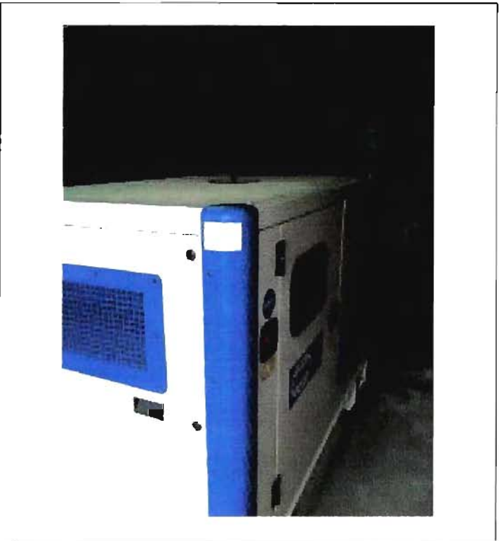
Construcción Torres de iluminación campo deportivo Estadio Municipal - Equipo electrógeno y luminarias en correcto funcionamiento.
