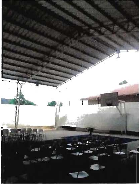
Multicancha Liceo Víctor Jara – 6 pórticos metálicos sin evacuación y drenaje de aguas lluvias.
