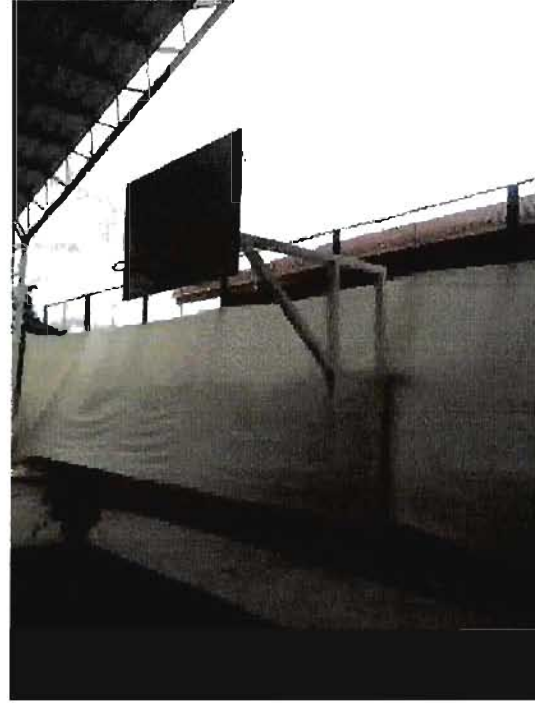
Multicancha Liceo Víctor Jara – tablero de basquetbol en línea de fondo de cancha, sin implementación deportiva, protección contra golpes y no cumple con diseño de proyecto.
