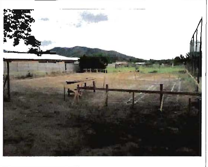
Construcción Skatepark, Parque Municipal - Situación actual de faenas: Trazados e instalación de faenas.
