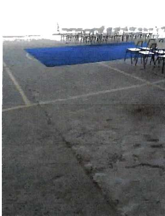
Multicancha Liceo Víctor Jara – situación paños no reparados (hasta media cancha)
