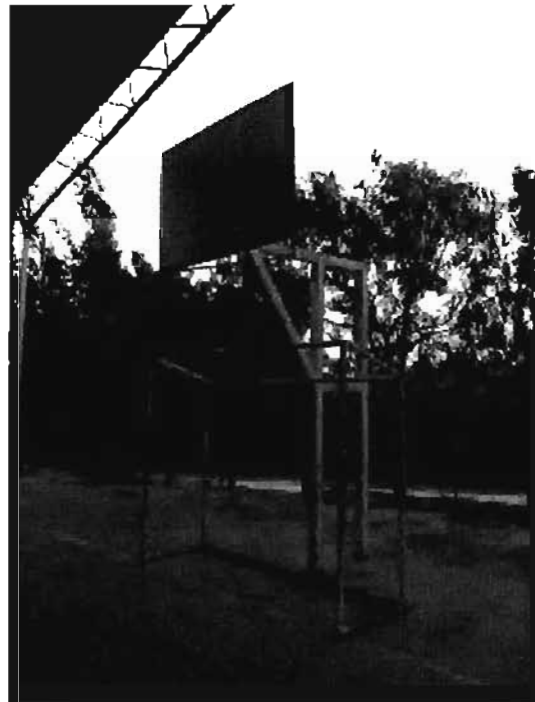
Multicancha Rinconada de Molineros - tablero de basquetbol sin implementación deportiva, protección contra golpes y no cumple con diseño de proyecto.
