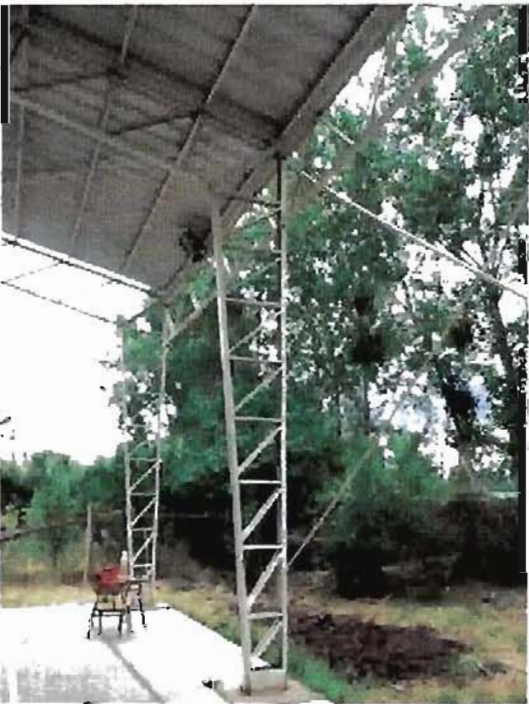
Multicancha Santa Victoria – omisión de ejecución partidas de evacuación y drenaje de aguas lluvias.
