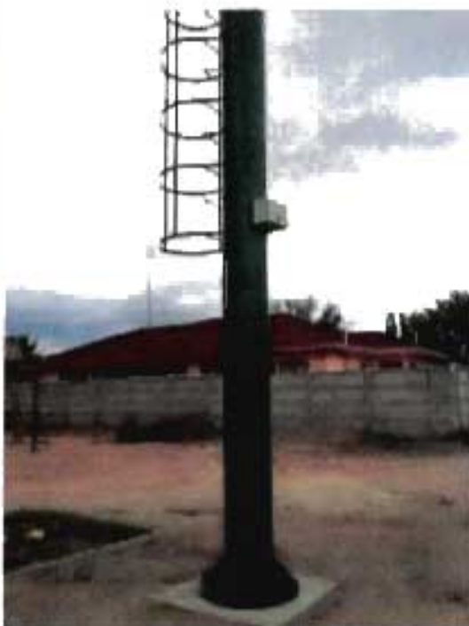
Construcción Torres de iluminación campo deportivo Estadio Municipal - Distancias y disposición según planimetría
