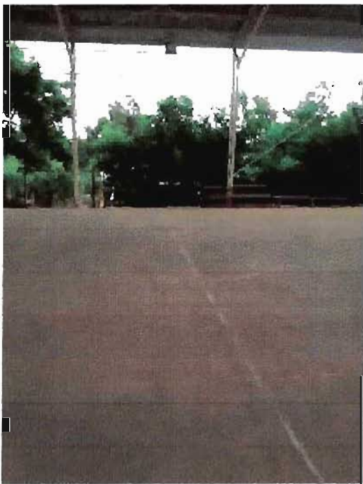
Multicancha Rinconada de Molineros - presencia de grietas transversales - omisión de ejecución partida de voleibol y tenis.
