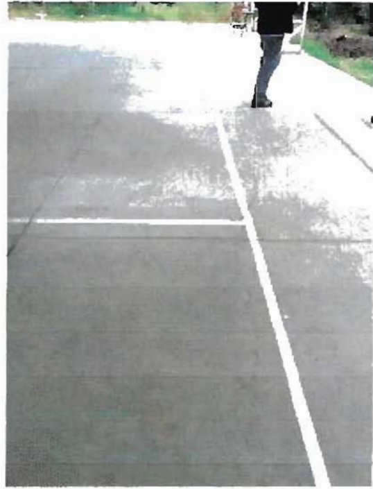
Multicancha Santa Victoria – Grieta sin reparar extensión oriente.
