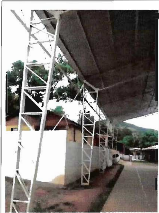
Multicancha Rinconada de Molineros - 6 pórticos metálicos - omisión de ejecución partidas de evacuación y drenaje de aguas lluvias.
